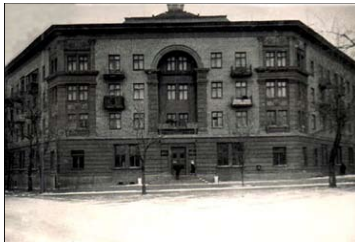
У 1954–1977 рр. у цьому приміщенні розташовувалася бібліотека. 1970-ті рр.
